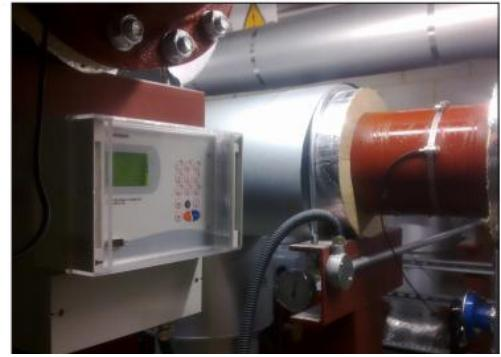
Применение KATflow 150 для измерения при помощи датчиков PT100
